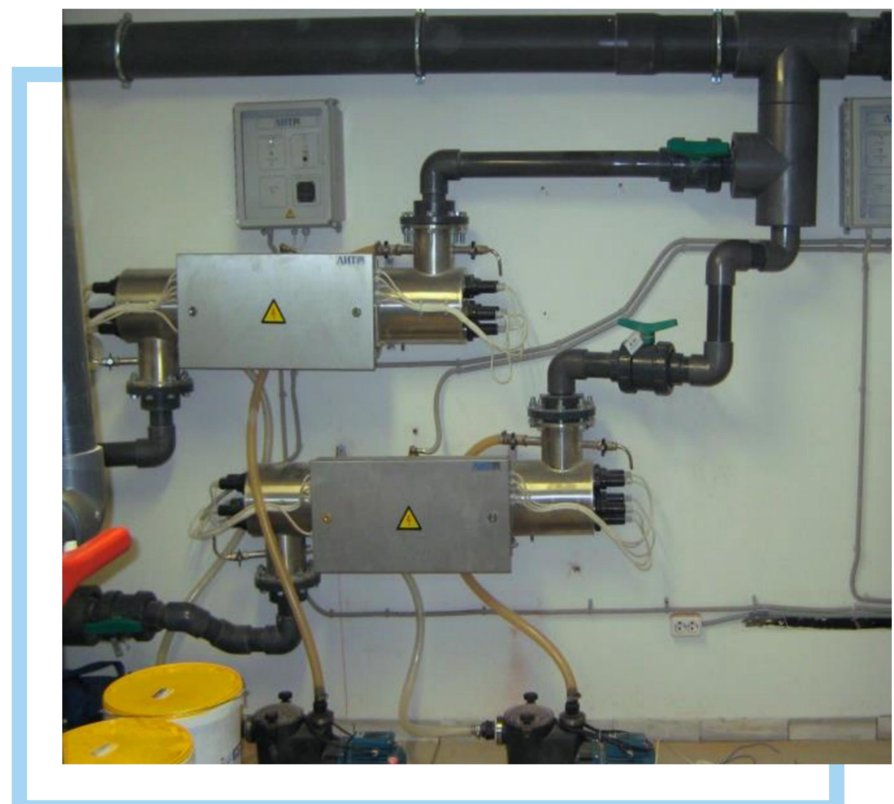
Этот метод улучшения качества воды наиболее эффективен и прост в эксплуатации не могут обеспечить консервацию воды. При использовании УФ дезинфекции происходит существенная экономия хлора за счет снижения количества микроорганизмов, уменьшение концентрации хлораминов в воде.
